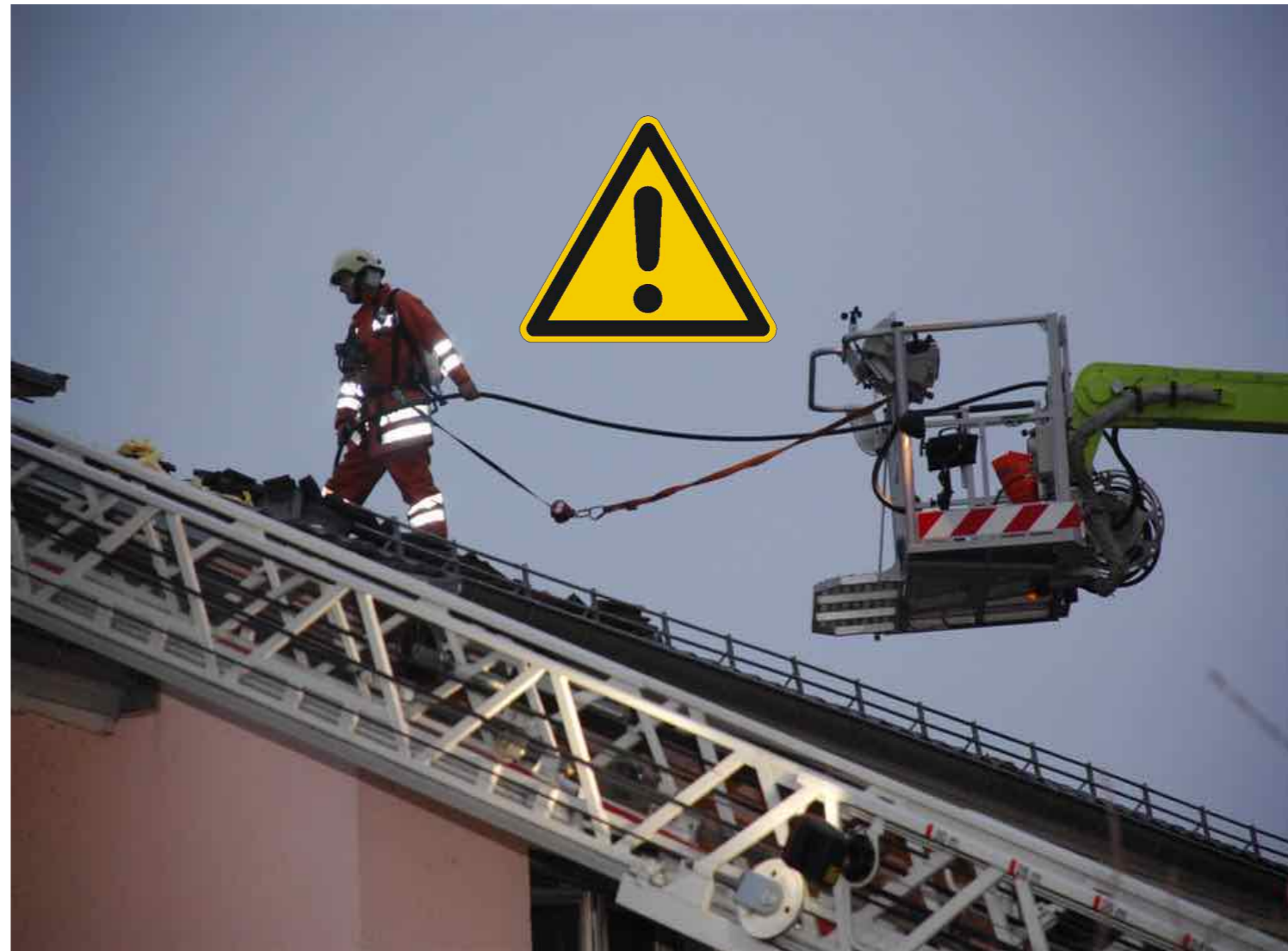
kumulierte Fehler: Auch für vollautomatische Sicherungen ist eine Ausbildung vorgeschrieben
