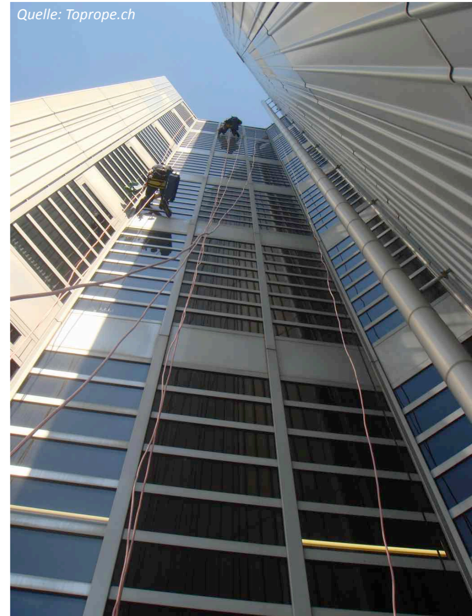
Höhenarbeiter bei der Arbeit am hängenden Seil
