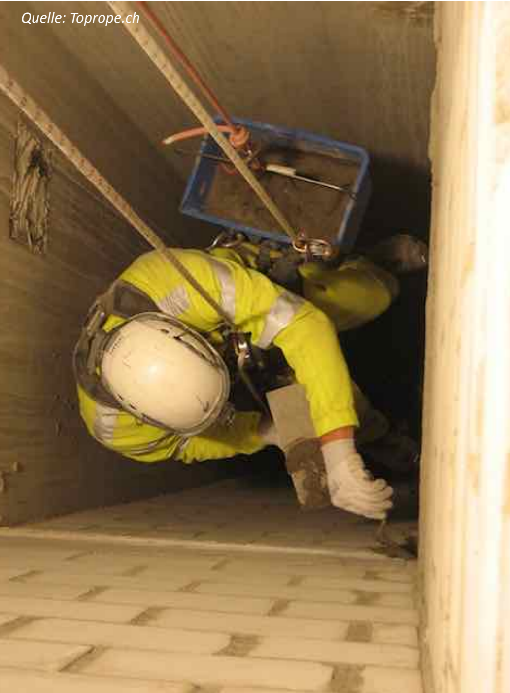
Arbeiten in einem 90m-Schacht
