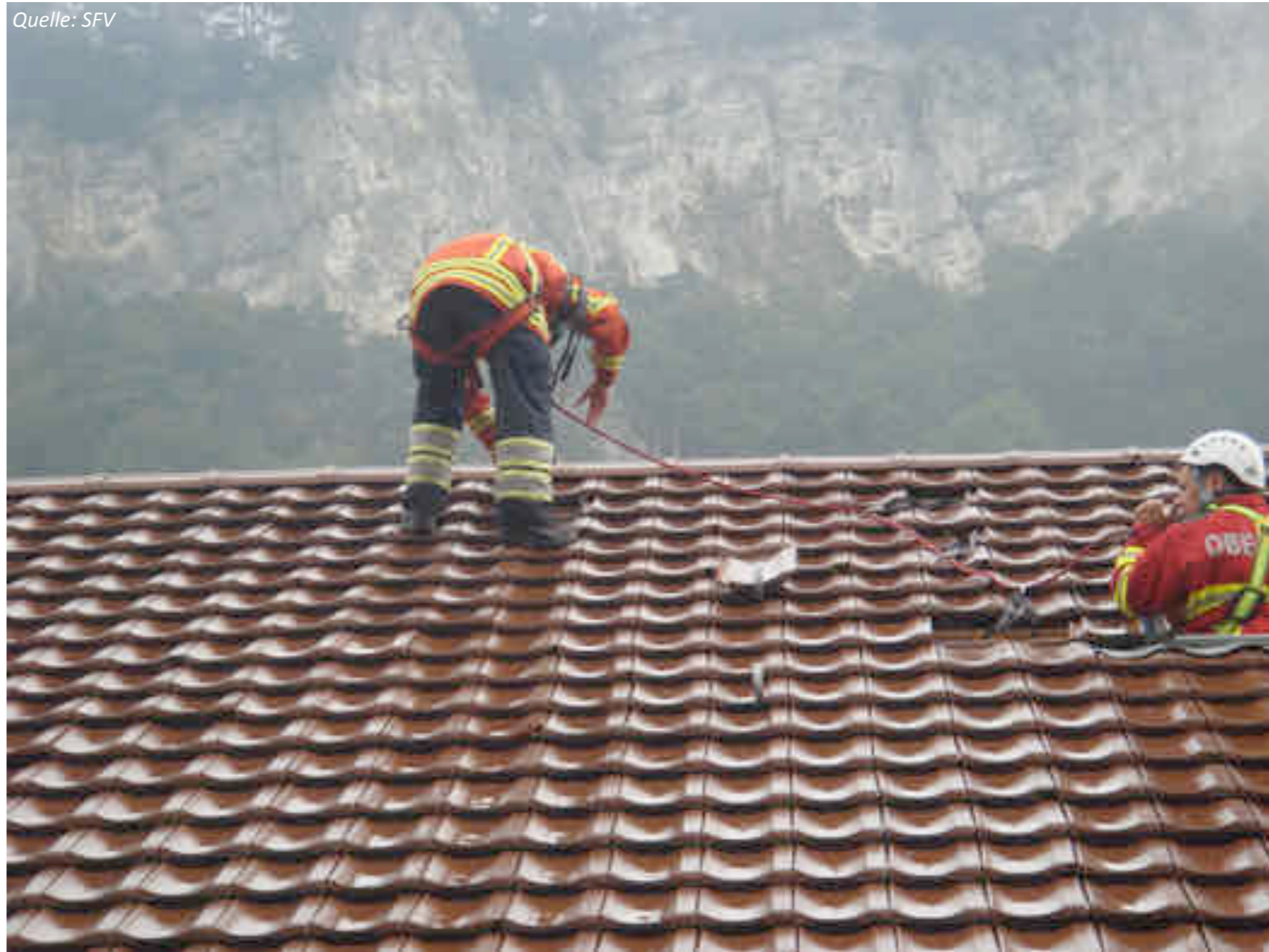
Sichern auf einem nassen Dach
