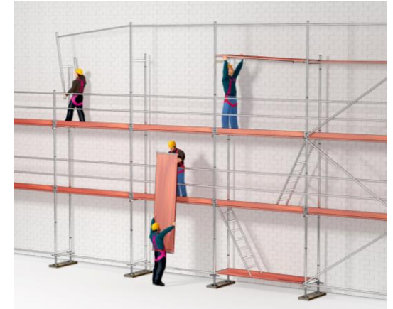
Bild 2: Montage: systembedingt vorlaufendes Geländer
