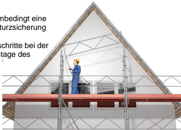
Bild 1: Montage: systembedingt vorlaufendes Geländer
