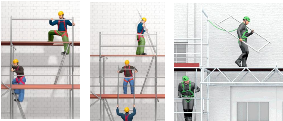
Bilder 5 - 7: Ablauf der Gerüstmontage unter Verwendung des MSGs und PSAgA
