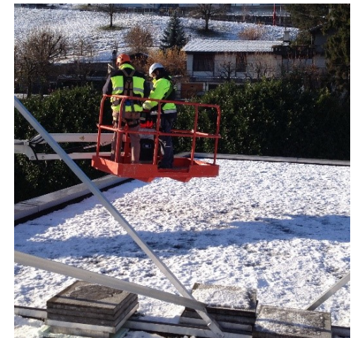
Bild 2: Erreichen eines hochgelegenen Arbeitsplatzes mittels Hubarbeitsbühne
