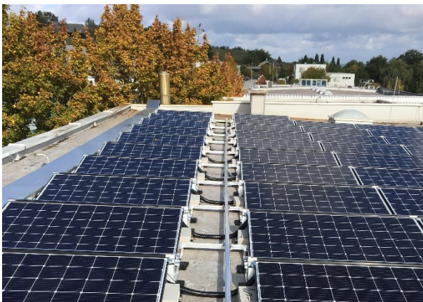
Auflastgehaltene lineare Anschlageneinrichtung für PSAgA (Schienensystem), in Kombination zertifiziert mit der Solarunterkonstruktion ist Bild: z. V.
