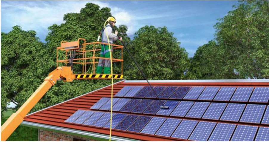
Reinigung PV-Anlage ab Arbeitsbühne ohne Betreten des Daches; Bild BG BAU
